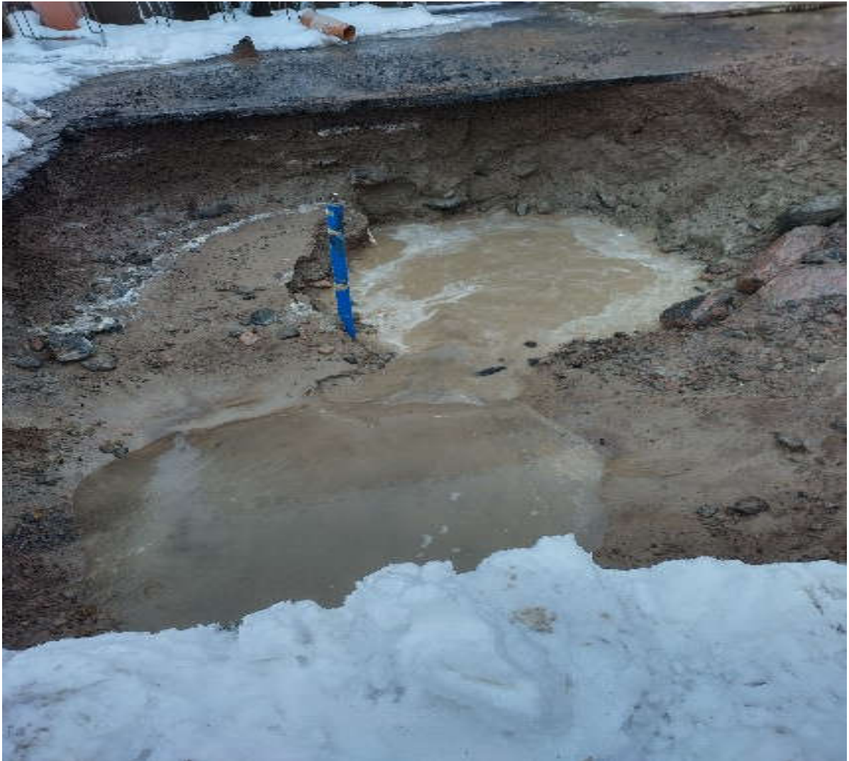
Savontie vesivuodon korjaus.
